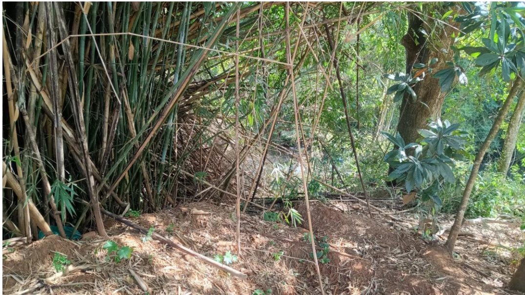
MARGEM ESQUERDA A JUSANTE
