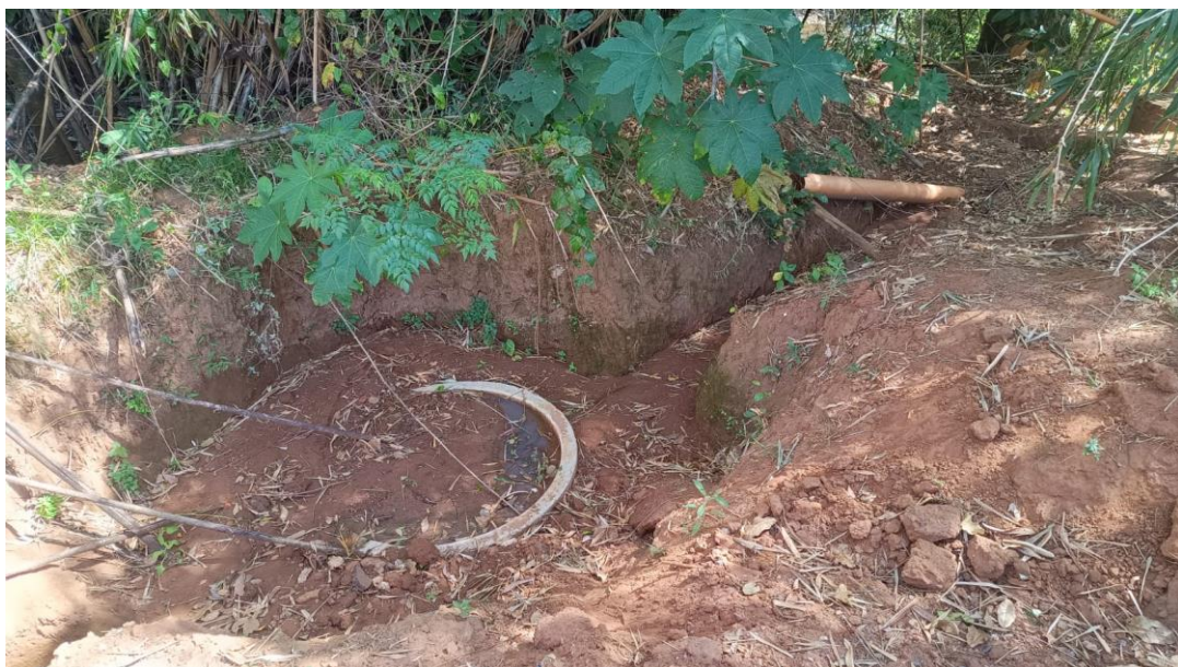
MARGEM ESQUERDA A JUSANTE
