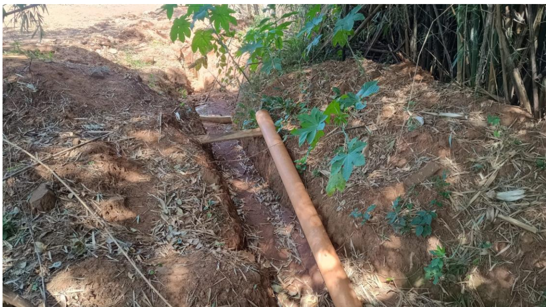
MARGEM ESQUERDA A JUSANTE
