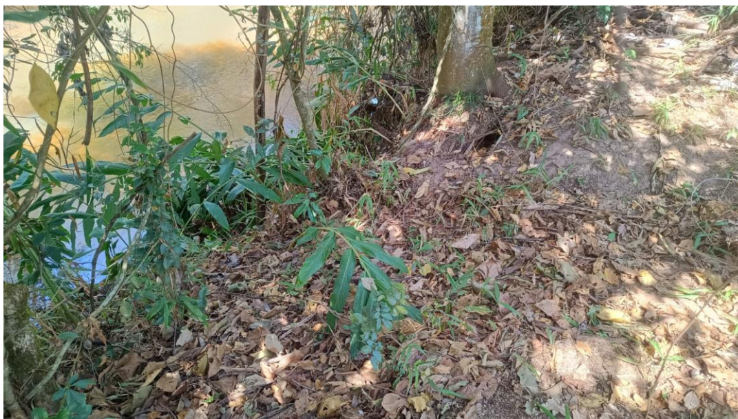
MARGEM DIREITA A JUSANTE
